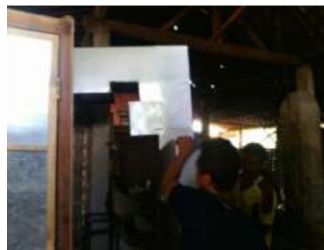
Gambar 7. Proses Instalasi Mesin Pengeri
